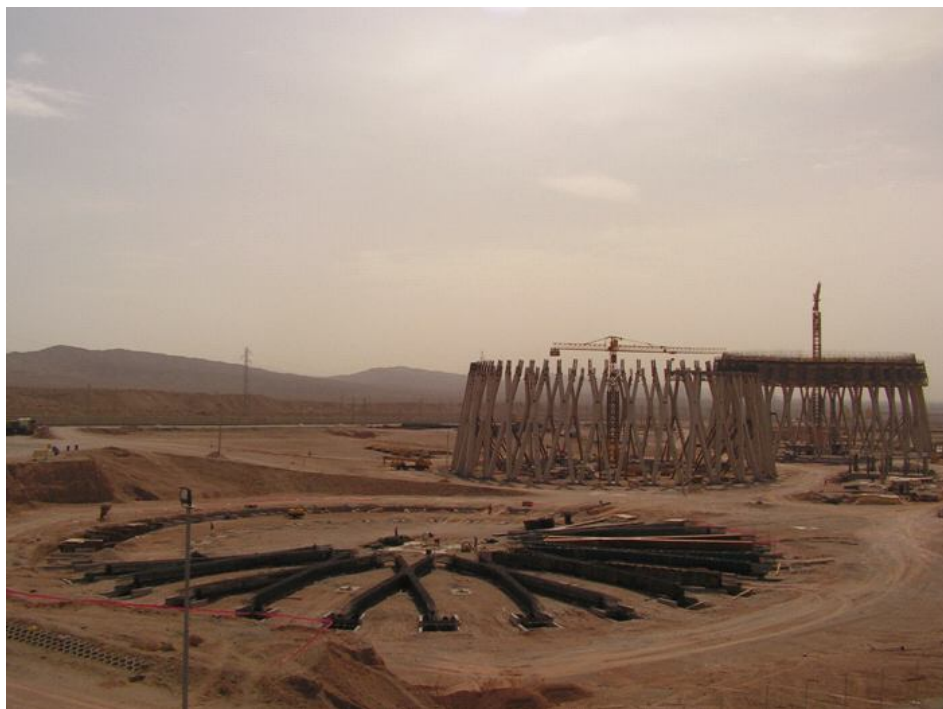
قرار گیری ۳ برج خنک کننده در کنار هم در نیروگاه سیکل ترکیبی دماوند
