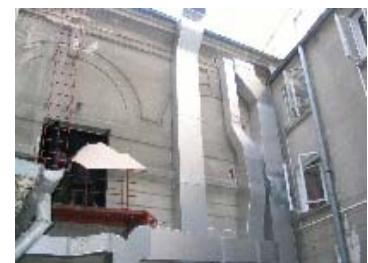
\* از خصوصیات یک عایق خوب کاهش مقدار انتقال حرارت بین دو سطح با درجه حرارت متفاوت میباشد. پلی یورتان منبسط شده که در این پانل ها مورد استفاده قرار میگیرد یکی از بهترین انواع عایق میباشد.
