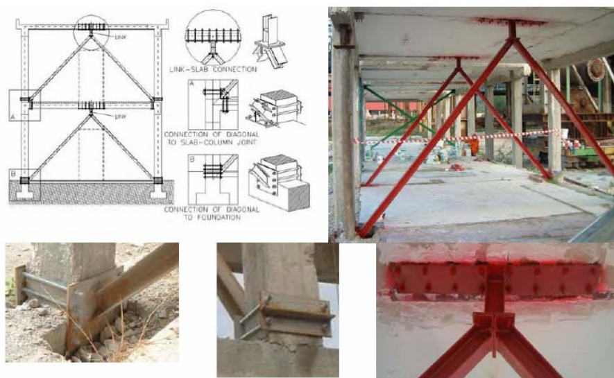
شکل ۸- کاربرد مهاربند برون محور (EB) همراه لینک قائم در مقاوم سازی قاب بتن آرمه [۱۷]
