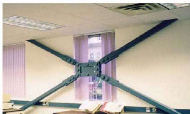
شکل ۱۴- میراگر اصطکاکی پال
