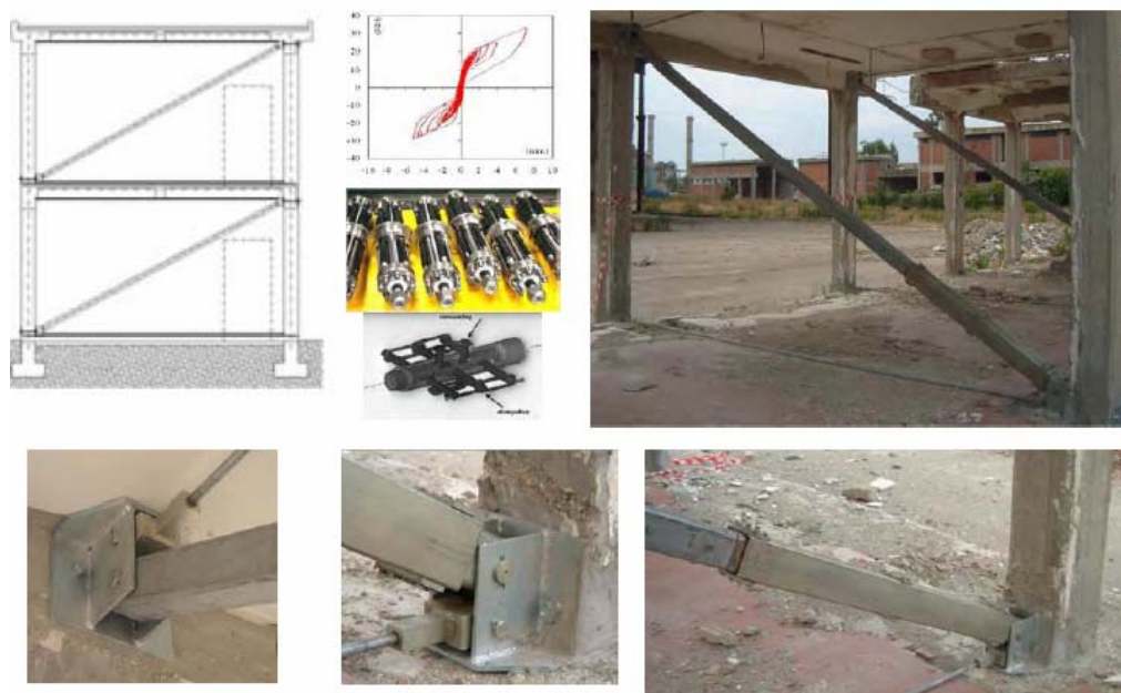
شکل ۱۲- کاربرد آلیاژ حافظه دار شکلی (SMA) Shape Memory Alloy (۱۷)
