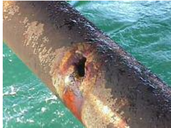
شکل ۳: وضعیت سوراخ شدن اعضای بالای آب
