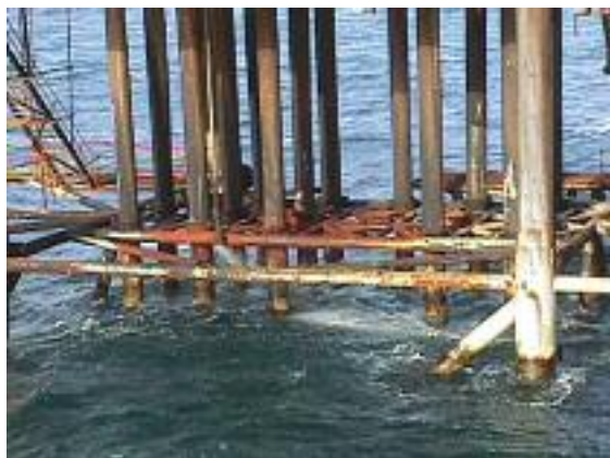
شکل ۱: تأثیر امواج بر روی پایه های سکو در ناحیه Splash Zone عامل خستگی اتصالات، خوردگی اعضا و کاهش مقاومت اتصالات در این ناحیه است.
