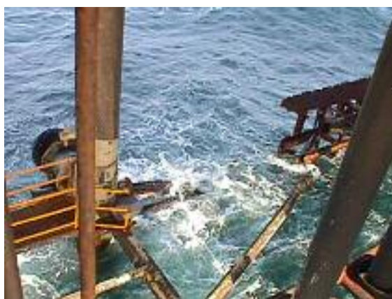
شکل ۲: آسیب های وارد به سکو بدلیل انفجار و ضربه کشتی در محل پهلوگیری شناورها که موجب از بین رفتن قسمتی از اعضای افقی گردیده است.
