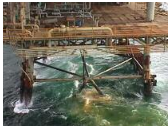
شکل ۱: تأثیر امواج بر روی پایه های سکو در ناحیه Splash Zone عامل خستگی اتصالات، خوردگی اعضا و کاهش مقاومت اتصالات در این ناحیه است.
