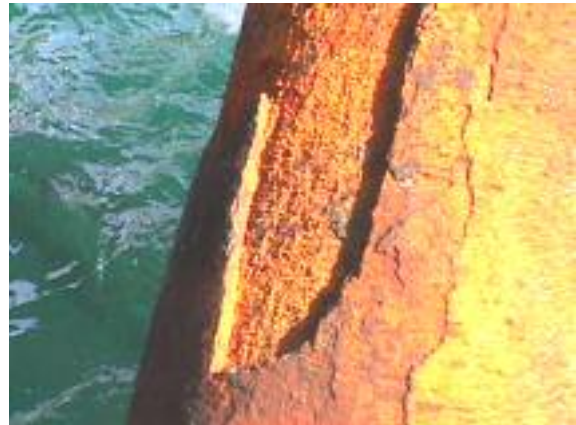
شکل ۴: خوردگی اعضا در تراز بالای جاکت
