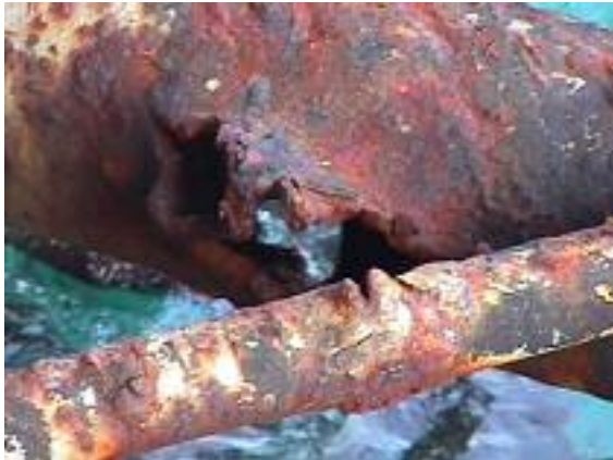
شکل ۳: وضعیت سوراخ شدن اعضای بالای آب
