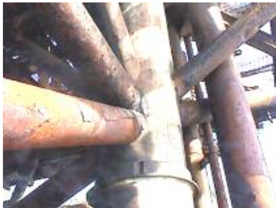
شکل ۵: آسیب های وارد به سکو بدلیل انفجار در عرشه (راست) و ترمیم ستون منفجر شده و تسریع خوردگی اعضا ناشی از آتش سوزی (چپ)
