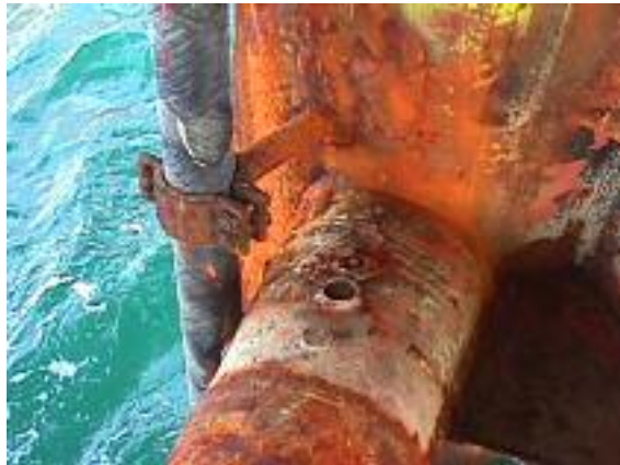
شکل ۴: خوردگی اعضا در تراز بالای جاکت
