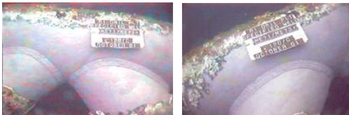
شکل ۶: بررسی وضعیت اتصالات در اعضای زیر آب توسط غواص
