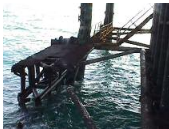
شکل ۲: آسیب های وارد به سکو بدلیل انفجار و ضربه کشتی در محل پهلوگیری شناورها که موجب از بین رفتن قسمتی از اعضای افقی گردیده است.
