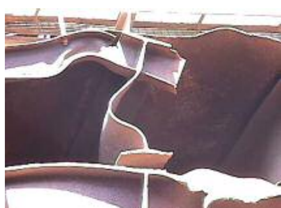
شکل ۵: آسیب های وارد به سکو بدلیل انفجار در عرشه (راست) و ترمیم ستون منفجر شده و تسریع خوردگی اعضا ناشی از آتش سوزی (چپ)
