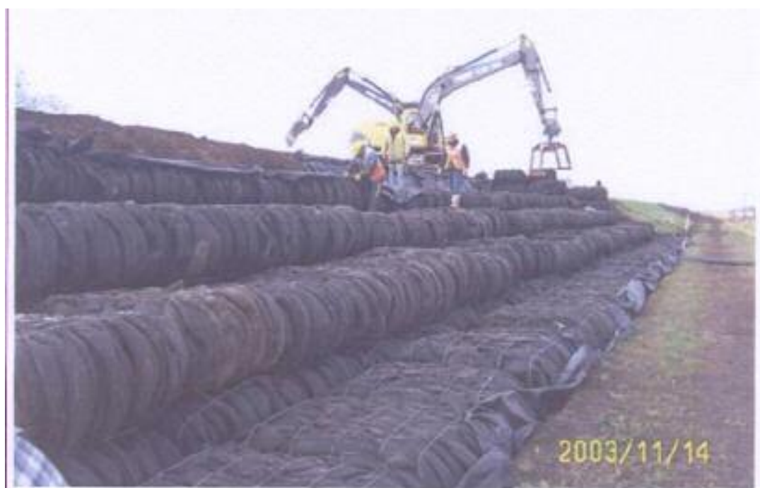
شکل (۸) نمونه ای از یک دیوار لاستیکی ساخته شده از بسته های تایر
