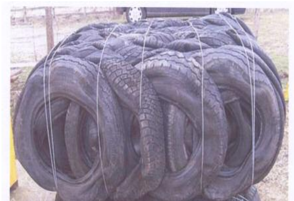
شکل (۷) بسته تایر برای ساخت دیوار لاستیکی
