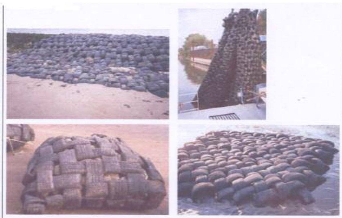
شکل (۲) صورتهای مختلف سیستم های ضربه گیربافته شده از لایه های تایر
