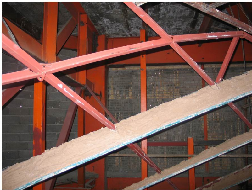
اجرای رسمی با جوک فیروزه ای بر روی قالب های فلزی
