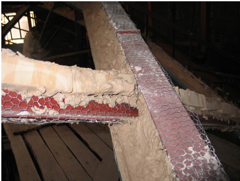
قالب مادر رسمی آجری که با تیر آهن شماره 16 اجرا شده است
