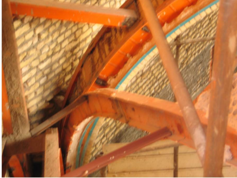
اسکلت رسمی آجری که قالب های اصلی آن با تیر آهن شماره 16 ساخته شده است
