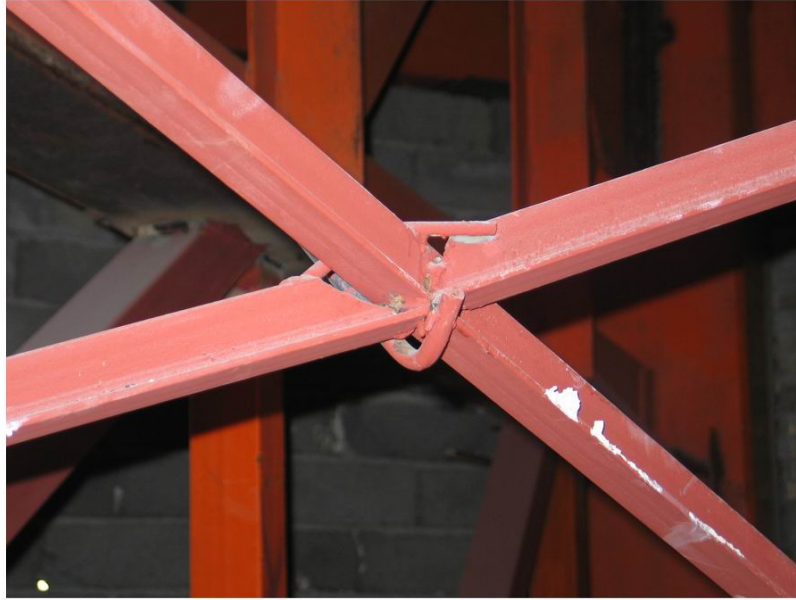
استفاده از سپری شماره 5 جهت زیر سازی قالب های فرعی رسمی
