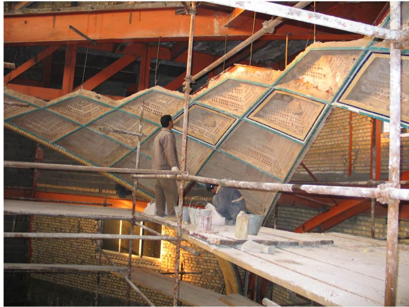
اجرای رسمی آجری با جوک فیروزه ای بر روی اسکلت فلزی
