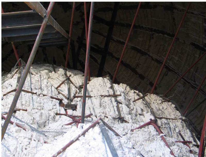
نمای از پشت رسمی گچی بعد از اجرای اندود گچ
