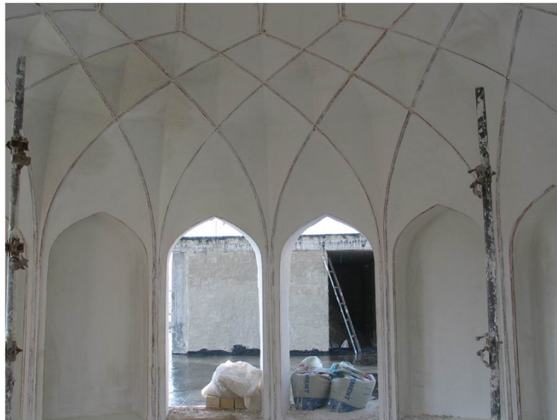
نمایی از رسمی با اسکلت فلزی ( سپری شماره 3 ) بعد از عملیات گچ کاری
