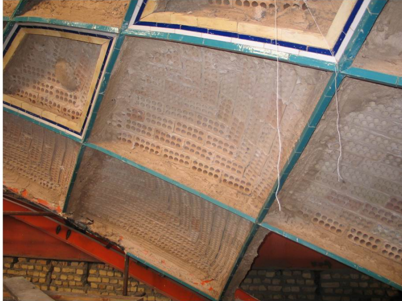
اجرای تیغه آجری داخل رسمی جهت نما کاری
