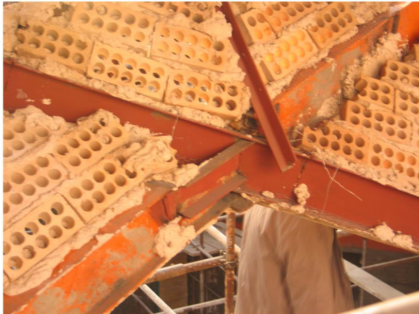
اسکلت رسمی آجری که قالب های اصلی آن با تیر آهن شماره 16 ساخته شده است
