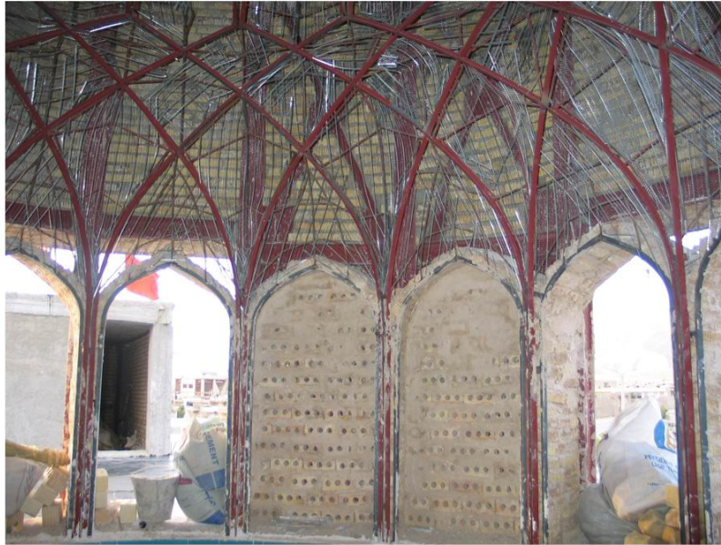
نمایی از رسمی با اسکلت فلزی ( سپری شماره 3 )
