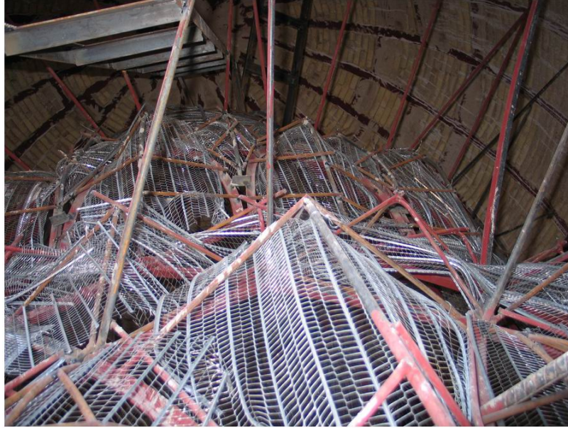
نمای از پشت رسمی که با سپری شماره 3 اجرا گردیده
