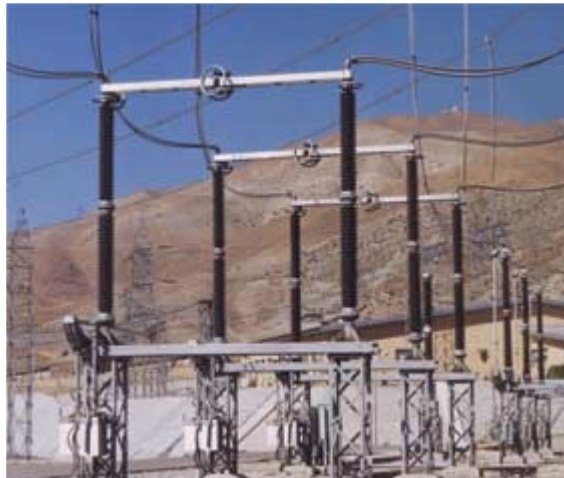
شکل (1) : سکسیونر افقی از نوع مرکز شکست
