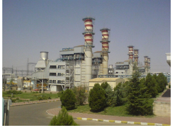
نمایی از فضای بیرونی واحد گازی نیروگاه
