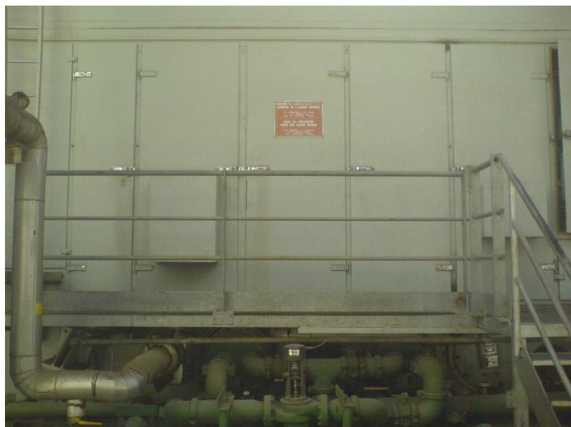
**اتاقی که در آن کمپرسور، محفظه احتراق و توربین واحد گازی قرار دارد و انتهای آن متصل به اگزوز است.**
