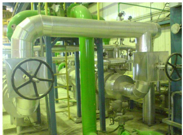
**تجهيزات خنک کنندگی آب کمکی که در خنک کاری روغنی که برای خنک کردن یاتاقانها مورد استفاده قرار می گیرد ، نیاز است.**
