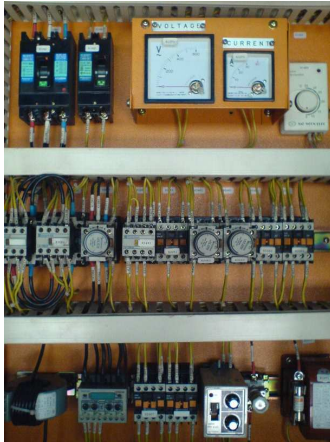
۱ - تصویر برد کنترل میکرو کنترلی جرثقیل
