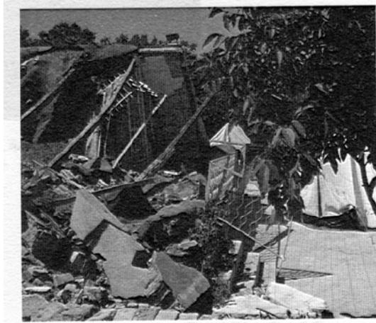
شکل ۳ - سازه اسکلت فلزی بدون مهاربند
