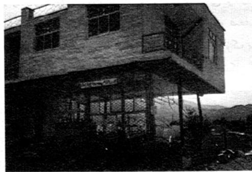
شکل ۱- جاری شدن ستون بدليل عدم استفاده از سیستم باربر جانبی [۶]
